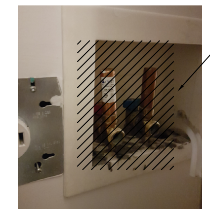
6 MAIN LEVEL - EX. WATER HAMMER ARRESTORS M1.01 SCALE: N.T.S
